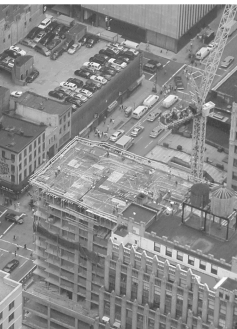
Bild 3. Hochhausbaustelle, New York Fig. 3. Skyscraper Building Site, New York
