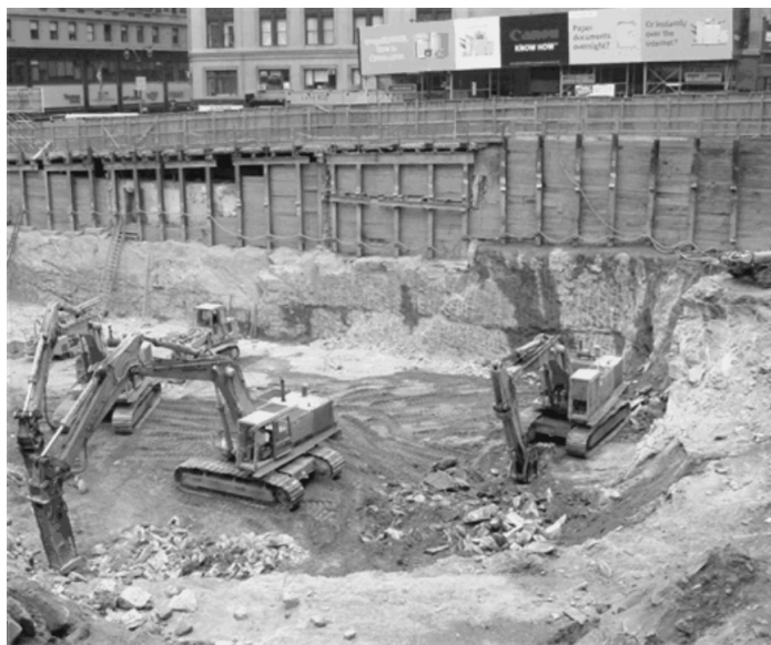
Bild 1. Baugrubenaushub, New York Fig. 1. Excavation, New York
