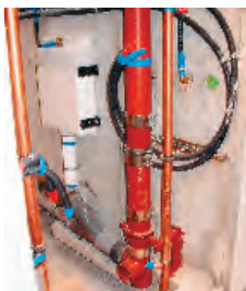
Rohre und Leitungen sind bereits montiert.
