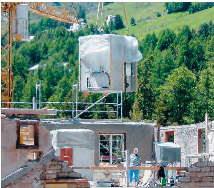
Ein fixfertiges Badezimmer - per Kran auf den Rohbau transportiert.
