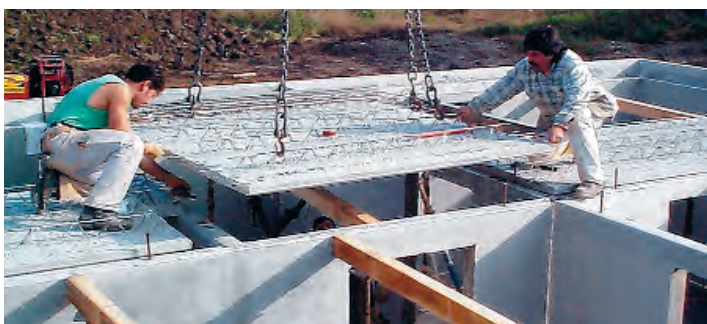
Die bewehrte Filigranplatte ergibt zusammen mit Ortbeton eine Verbunddecke.
