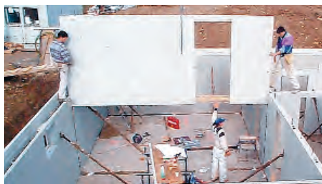
Aussparungen oder Einbauten können bereits im Werk berücksichtigt werden.
