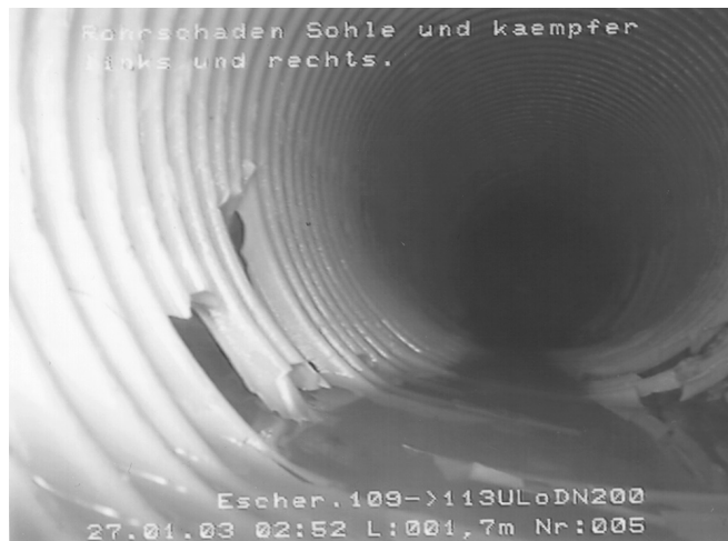
Bild 4. Rohrschaden in Kämpfer und Sohle durch falsche Materialwahl und zu große Reinigungsbeanspruchung
