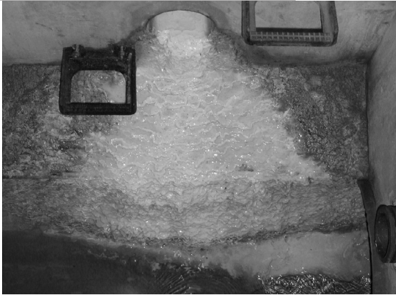
Bild 7. Versinterungsschwerpunkt infolge der Einleitung der Querableitungen in die Sammelleitung über Abstürze (Escherberg-Tunnel, Schacht Sammelleitung, Block 309) Fig. 7. Main sintering as a result of outlet the lateral pipes into collecting pipe over falls (Escherberg-tunnel, manhole of collecting pipe, sector 309)
