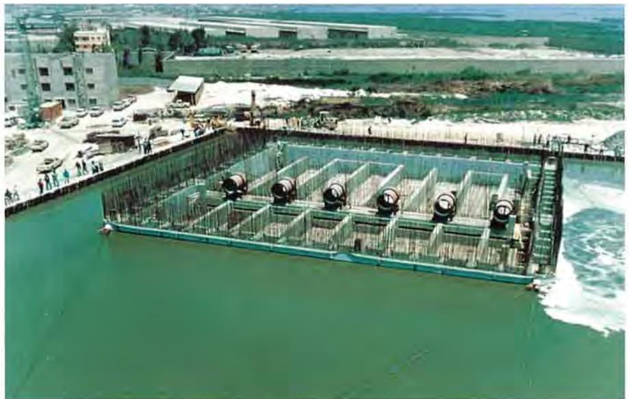
Bild 2: Schwimmend hergestellte Pumpstation, Alexandria Ägypten
